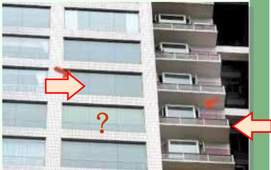
防火樓板應突出外牆面50cm以上，但與樓板交接處之外牆面高度達90cm以上，且外牆構造具有樓地板同等防火時效者，得免突出。
