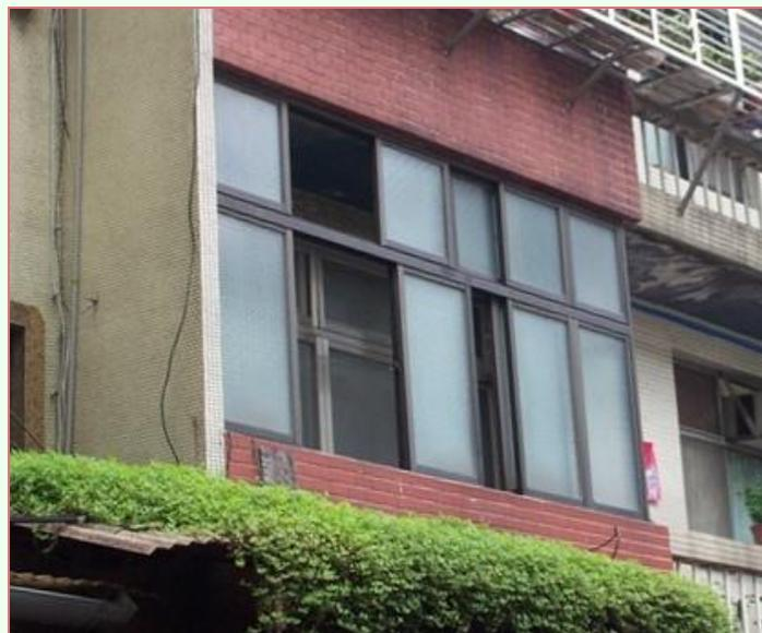
▲在陽台加設窗戶，外牆未拆除者，得沿其欄杆外緣施作，但不得突出外牆面
