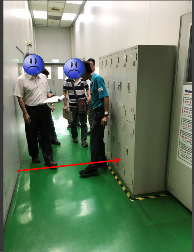
走廊放置儲藏櫃致寬度不符
