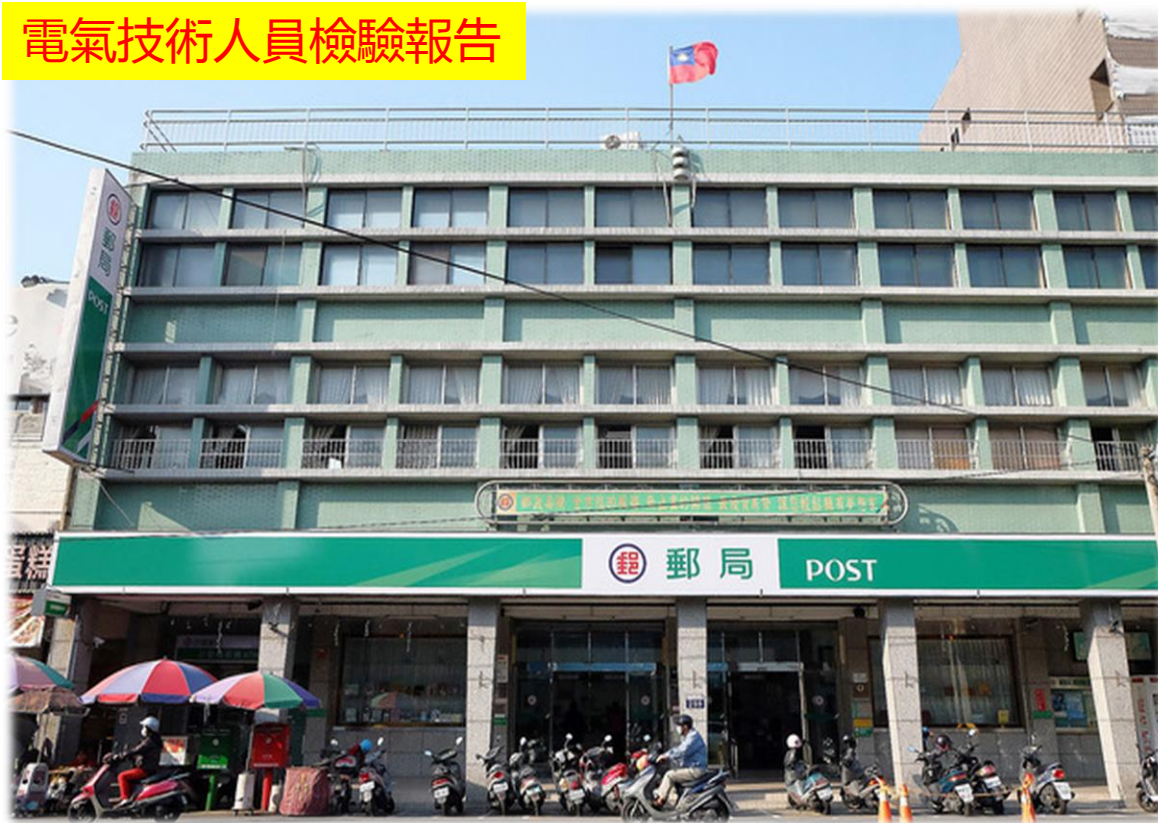
用電設備安全
