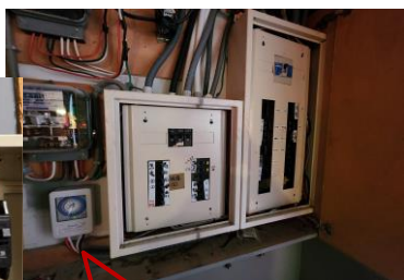
誤將計時器或一般無熔絲開關視為漏電斷路器
