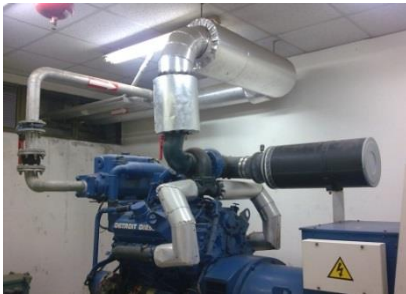
排煙管防高溫包覆
