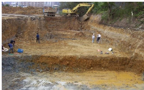
圖1. 地下室大底版開挖
