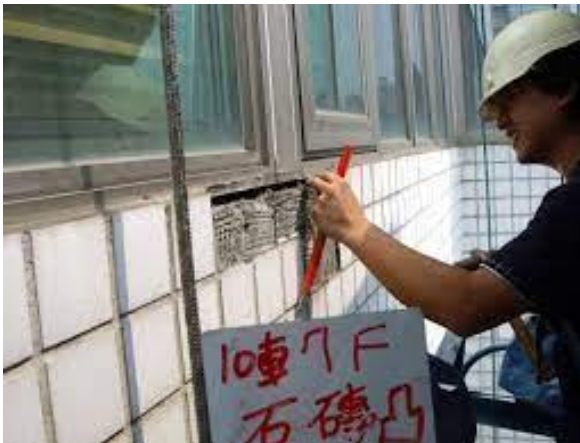
外牆飾面材料剝落檢查補強
