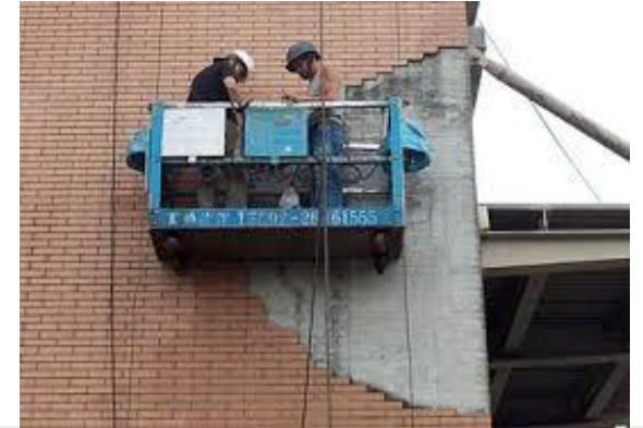
外牆飾面材料剝落檢查補強
