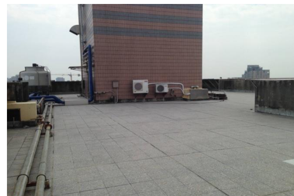
屋頂避難平台
