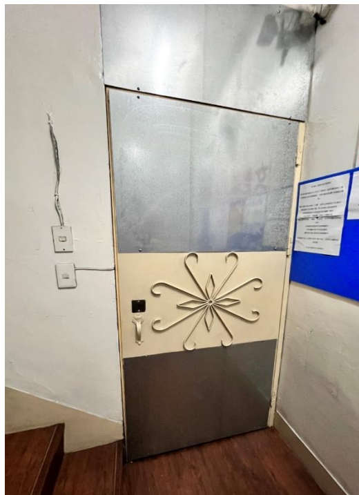
3F樓梯 外側鐵 門
