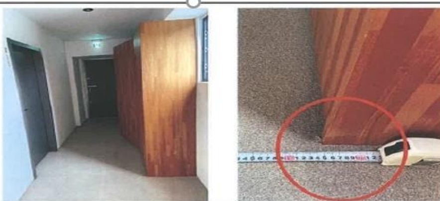
現場設置固定櫃體，走廊寬度為 115cm<120cm
