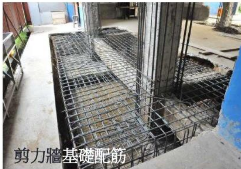
剪力牆植筋與配筋
