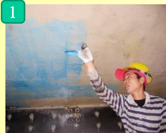
▲ 第一層積層樹脂 ▲ 操作一層碳纖貼附 ▲ 第二層積層樹脂
