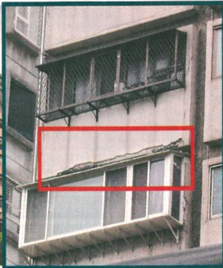
←民權東路2段京華大廈5樓及6樓交界處(上圖紅框處)，老舊磁磚剝落砸中女童頭部，6樓住戶遭台北市建管處開罰6萬元罰鍰。
