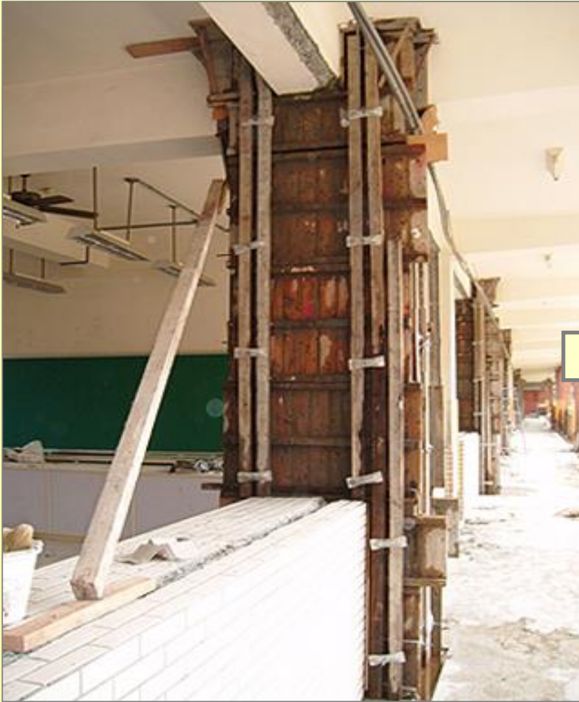
3 模板組立後澆築 混凝土
