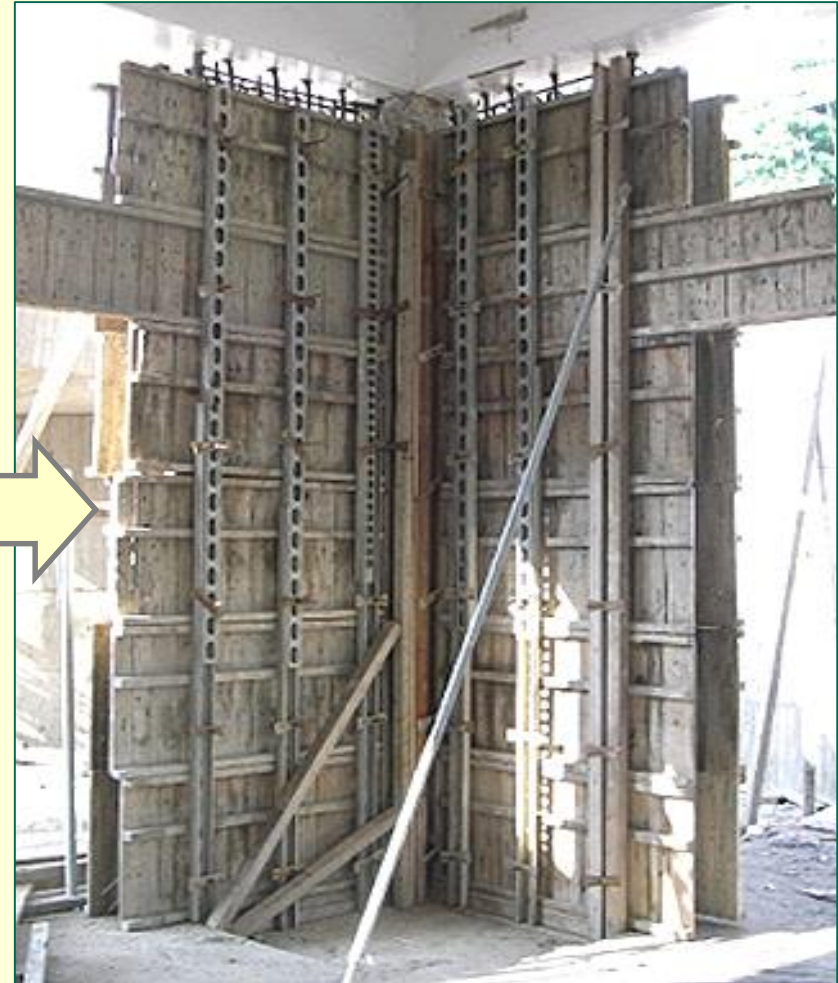
4 組立模板並進行混凝土灌漿。混凝土凝固後，取下模板
