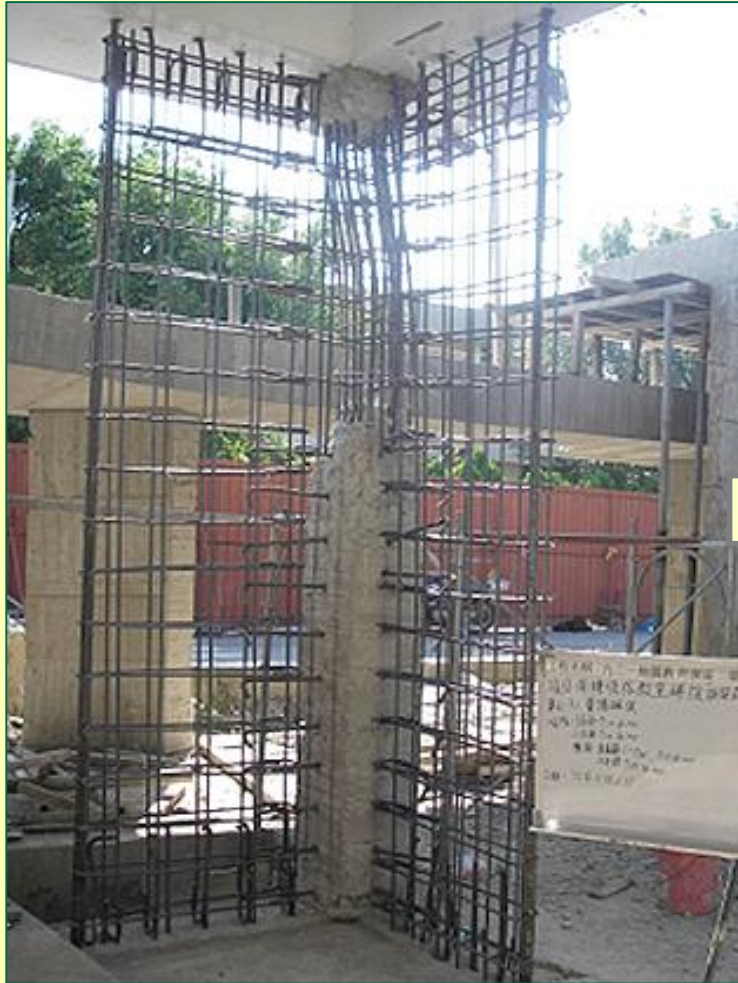
3 補強柱體裂縫後，鑽孔植入鋼筋並綁扎成牆柱形
